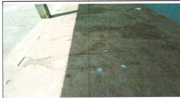
Foto 4: Mejoramiento y cambio de piso corredor 1
