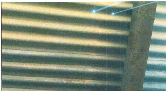
Foto 3: Estructura de techo.
