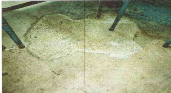
Foto 2: Mejoramiento y cambio de piso dentro de las aulas.
