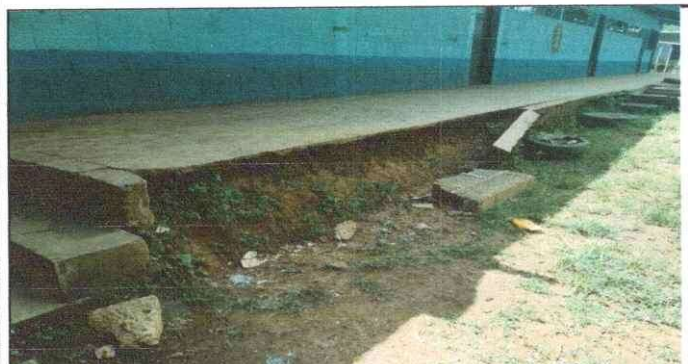
Foto 5: Reparación de piso en área de corredor 2
